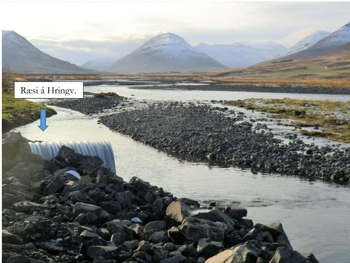
Mynd 6-16: Megin farvegur að færast til austurs að Hringvegi og árbotninn nánast að verða í sömu hæð og vegurinn. Svæði E9. Horft til suðvesturs (mynd GHG).
